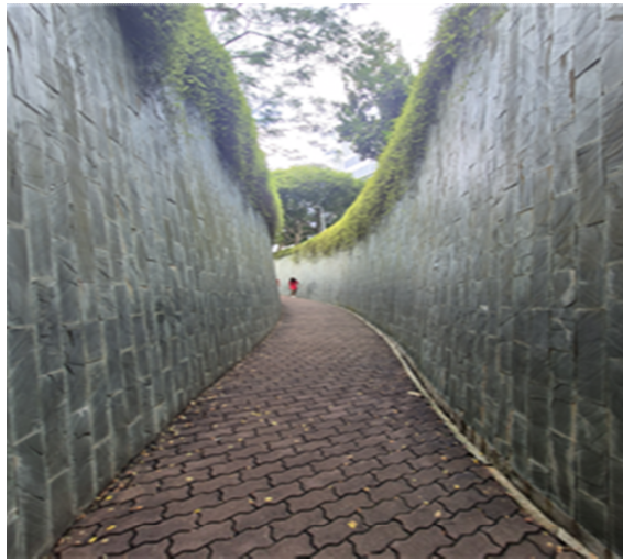
공원 입구에 위치한 Tree Tunnel은 배수, 통로 기능을 가지고 있는 실용적 구조물
