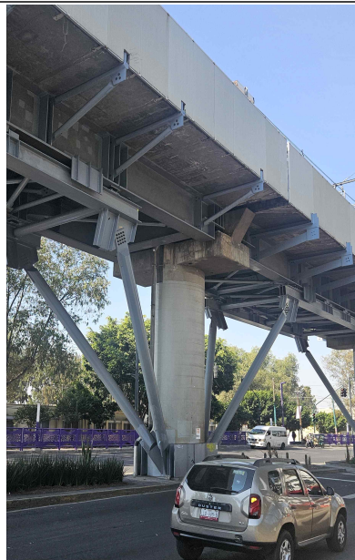
콘크리트 교각 주위를 거대한 강철 프레임과 지지대
