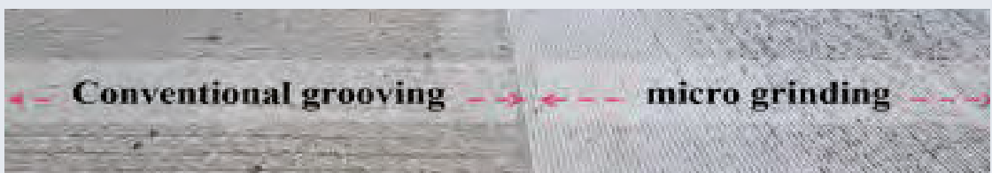
그림 1. 도로 그라인딩 공법의 예시
