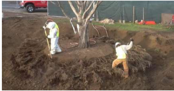
그림 11. Airspade를 활용한 수목 나근 이식법
