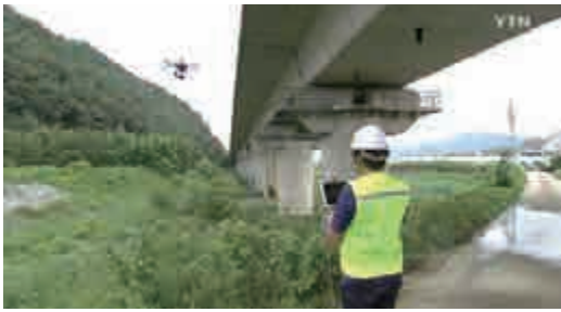
[그림 5] 시설물 유지관리를 위한 드론 계측 (출처 : YTN 뉴스)
