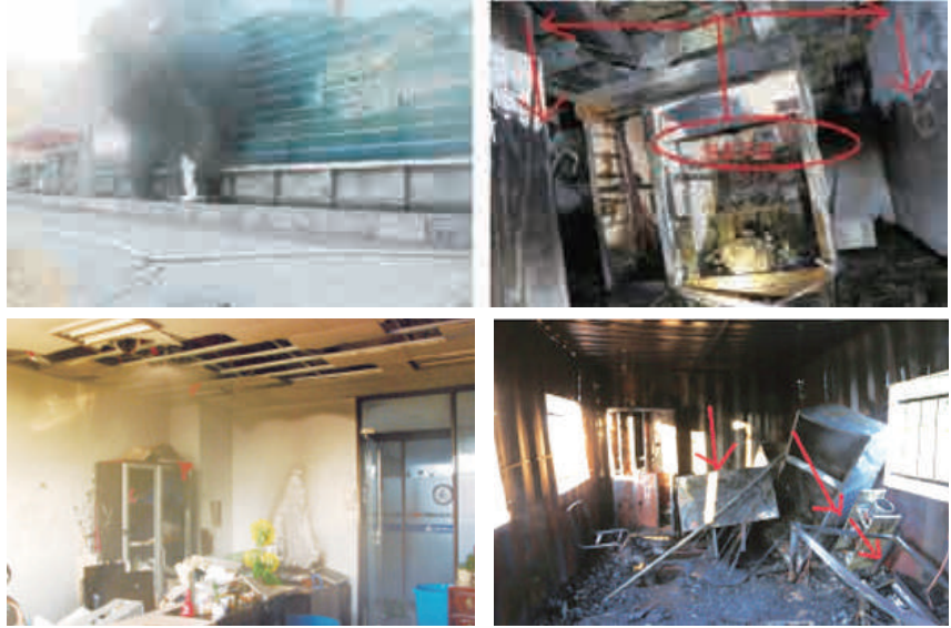
[그림 1] 포항지진에 의한 포항시립미술관(상단좌우), 한동대학교 연구실(하단좌측), 청하면 컨테이너 화재(2017 포항 지진백서, 행정안전부, 2018)
